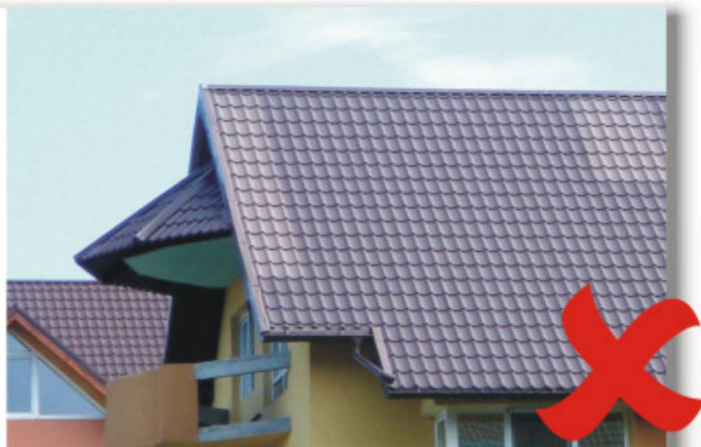
La **RUFSTER** comenzile sunt realizate din aceleași loturi de materie primă astfel încât dumneavoastră puteți avea siguranța că toate elementele sistemului de acoperiș au aceleași proprietăți fizice: culoare, grosime, finisaj sau cantitate de zinc.
